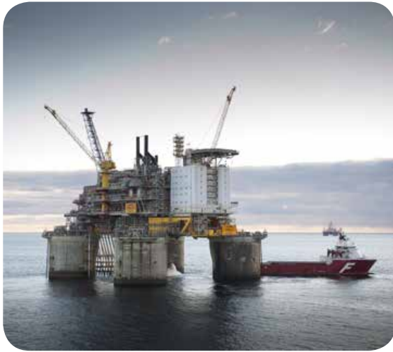
Photo: Øyvind Hagen - Statoil ASA
